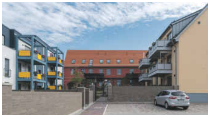
Foto: Klosterhof Außenanlage
