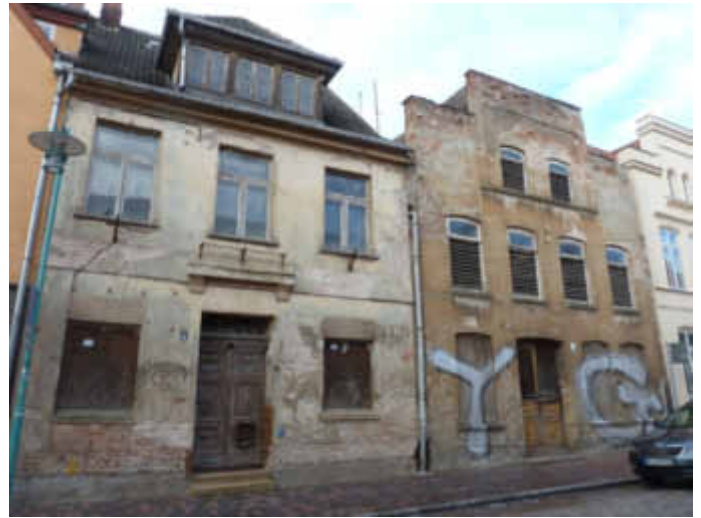
Bauzustand der Gebäude Lange Straße 45 und 46
