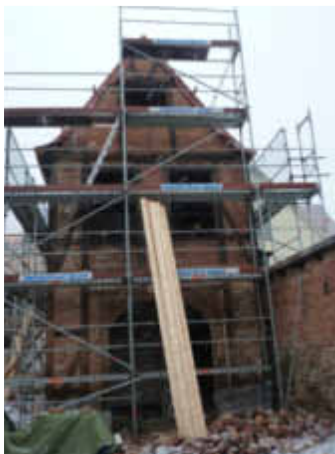
Bauarbeiten am Kendladen, aufgenommen am 13.01.2016
