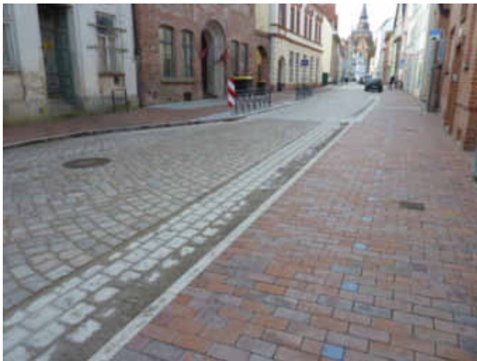
Straßenbau Mühlenstraße im Bereich des Derz'schen Hauses Nr. 48
