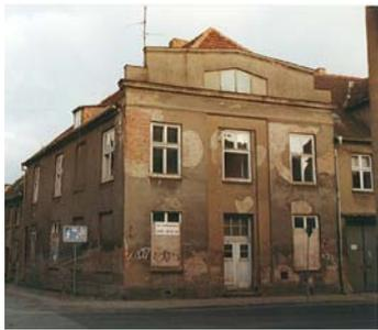
Das Gebäude Kattrepel 5 musste 1997 von der damaligen Eigentümerin im Zuge eines Brandschadens abgebrochen werden. Die Gebäude Kattrepel 4 sowie Lange Straße 10 konnten aufgrund der erheblich zerstörten Bausubstanz nicht mehr erhalten werden und wurden 2002 abgerissen. Im Rahmen
